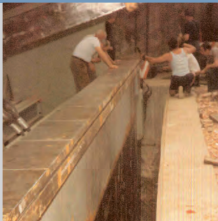
Fondazione pressa, profonda. 6 m
