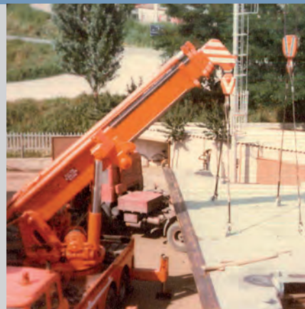
Fasi di montaggio pressa
